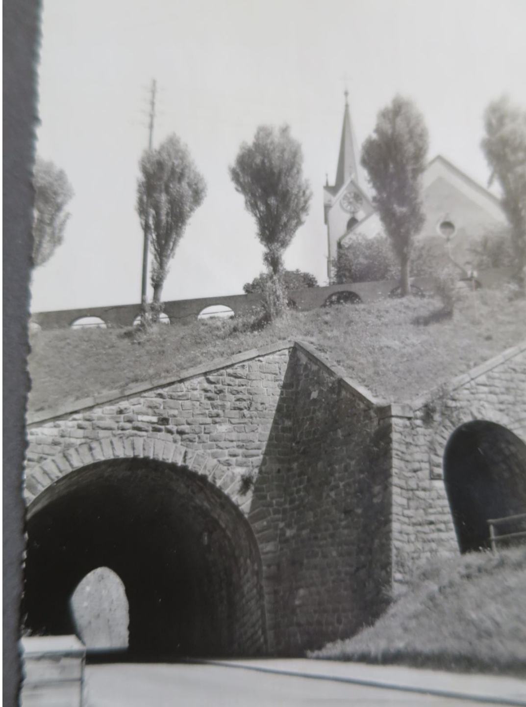
Mühlebüel-Tunnel mit altem AB – Bahntunnel und alter Kirche
